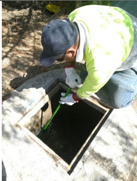
Limpieza cámara anterior a canaleta Parshall
