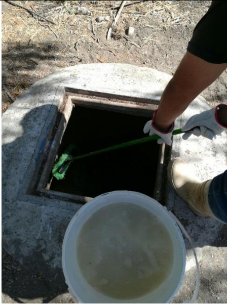
Limpieza cámara anterior a canaleta Parshall
